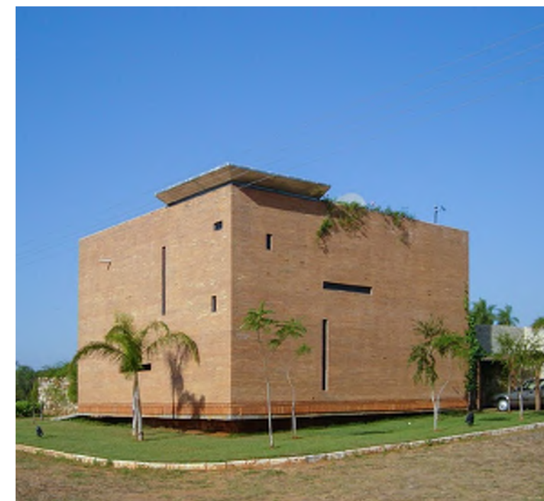
Casa Torre de Control
